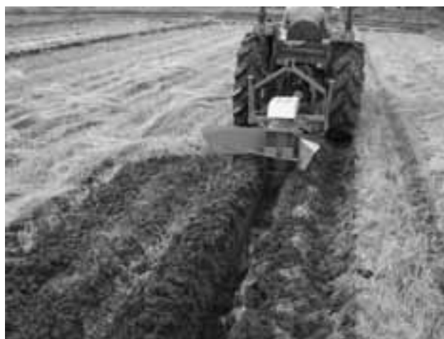
写真1 オーガトレンチャによる明渠設置
